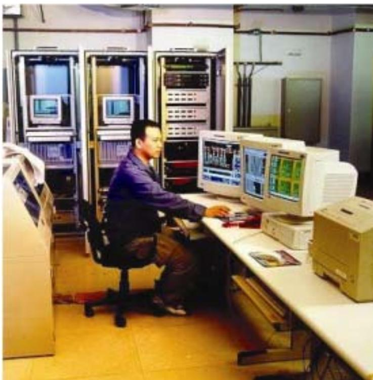
圖十四、行控中心明電舍電力遙控設備全覽（照片後方左手邊第一第二機櫃為系統主機，右方機櫃則放置 GPS、TCI Server、通訊協定 Converter 及網路 hub）
