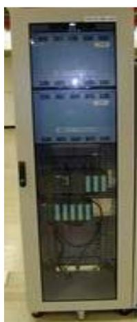
圖十一、下方中間部份為供電系統與號誌標的界面 MBC (Mimic Board Controller)
