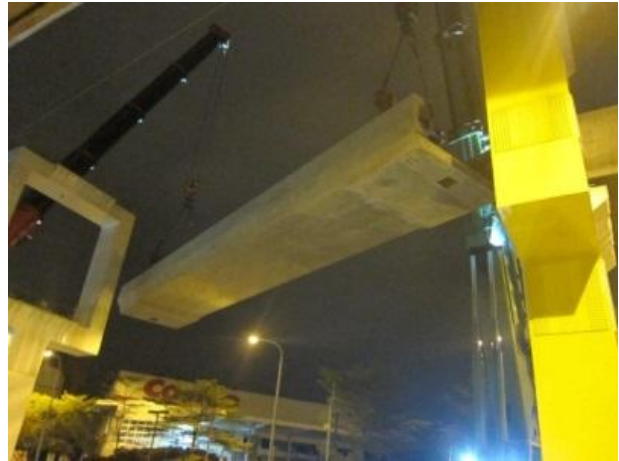
疊式高架橋 U 型梁吊裝
