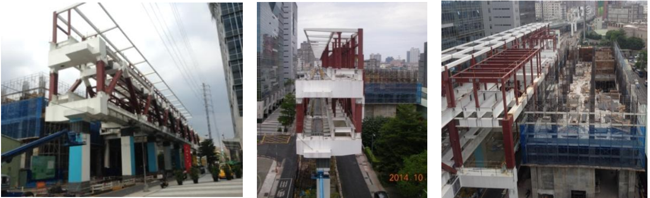
圖 8 疊式車站現場施作照片
