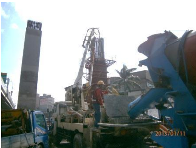
圖 19 泵送作業速度不可過快
