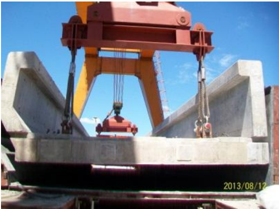
預鑄場 U 型梁吊裝脫模
