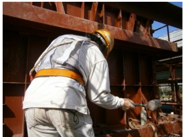
圖 20 輕敲外模藉以消除氣泡
