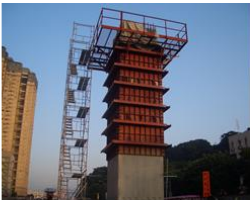
圖 25 橋墩模板高度
