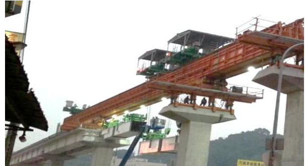
節塊 1 鋼梁吊裝
