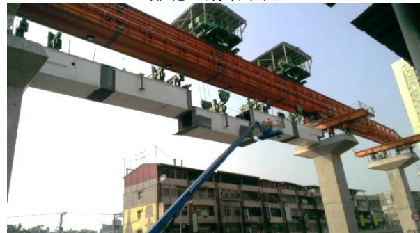
節塊 3 鋼梁閉合吊裝
