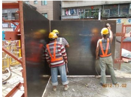
圖 17 模版表面以砂輪機整平
