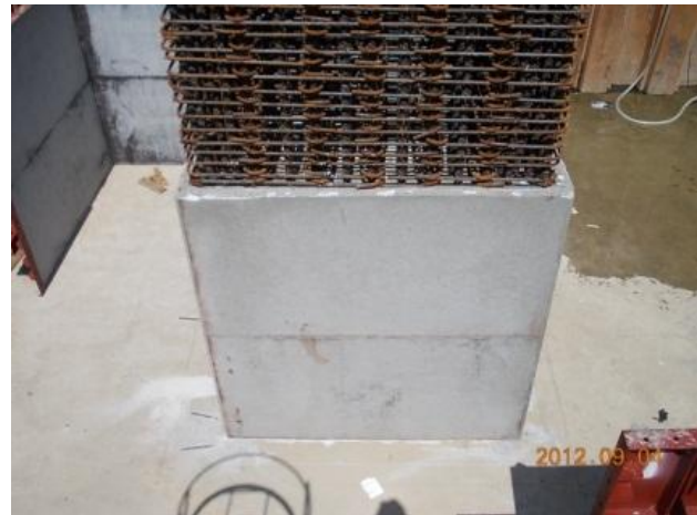
圖 22 養護後墩柱品質良好
