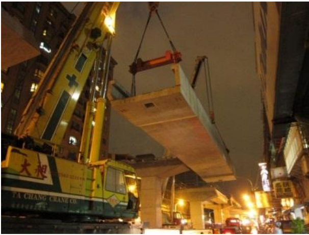
側式高架橋 U 型梁吊裝
