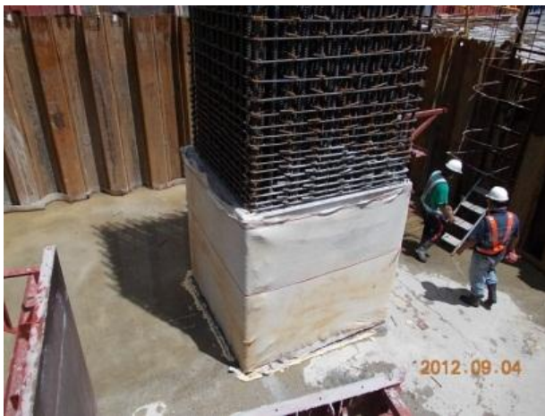
圖 21 拆模後覆蓋不透水材料養護
