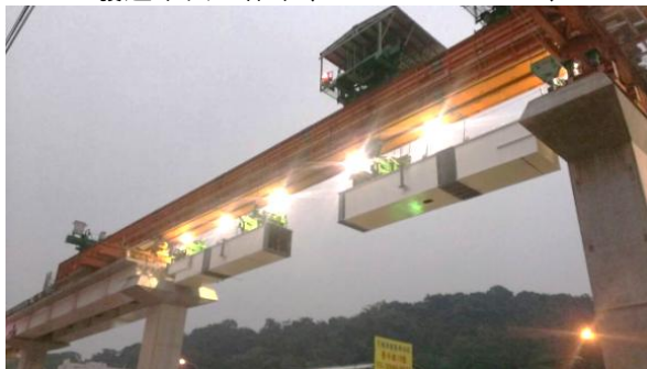
節塊 2 鋼梁吊裝
