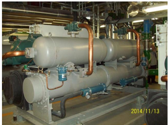
圖 5 螺旋式冰水主機
