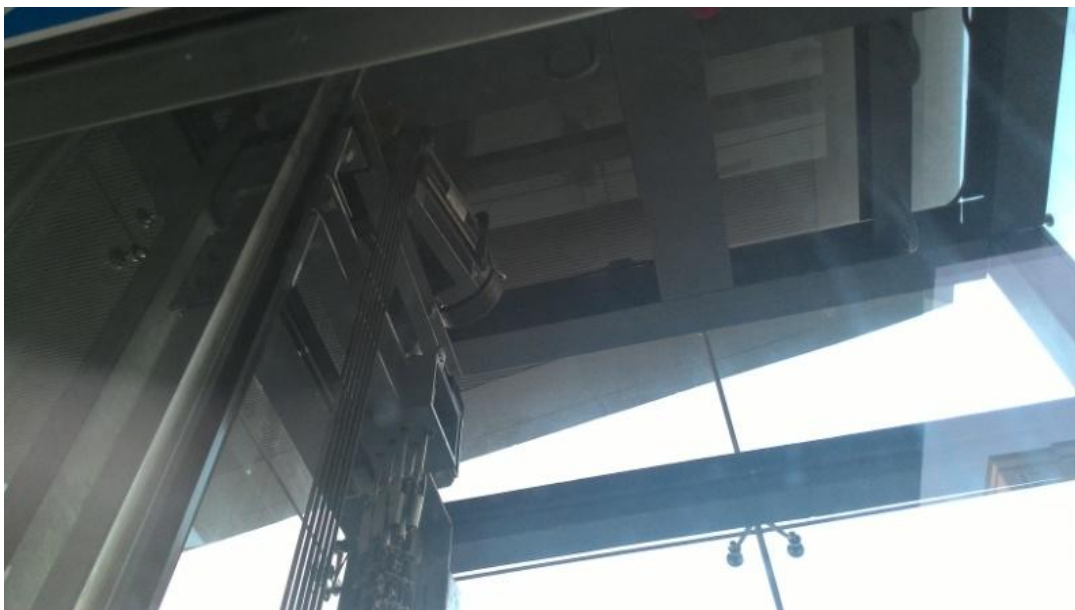
圖 8 無機房電梯之永磁馬達(圓柱式，馬達位於升降道頂部) (2)
