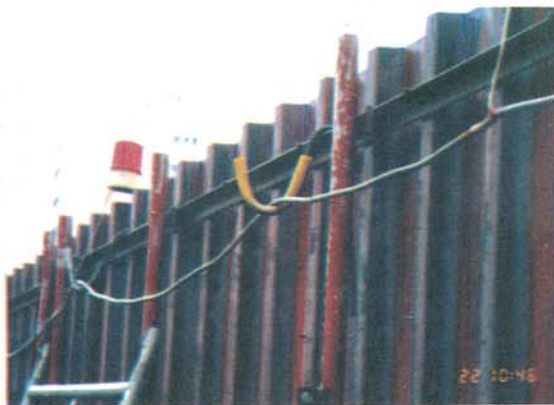
↑圖六：工區之導線均絕緣整齊吊掛於圍籬上
