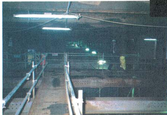
←圖十二：工區內之照明設備皆整齊並聯接電，皆使用重負荷電纜導線
