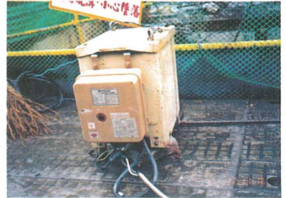
圖一：電焊機加裝自動電擊防止裝置
