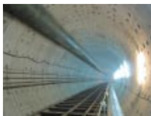
潛盾隧道施工
