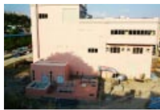
設施變電站及汙水廠施工現況
