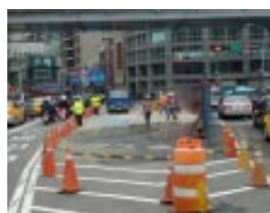
臺北端延平北路回填復舊交通改道
