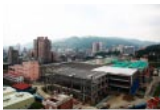
維修工廠施工現況
