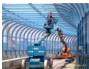
三重端高架隔音牆施作
