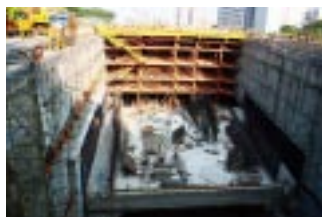
明挖覆蓋段隧道施工現況
