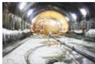
山岳隧道施工現況
