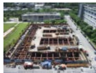
C出入口聯合開發基地 土方開挖施作
