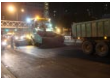
瀝青混凝土銑刨加鋪夜間 施工
