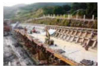
護坡施工現況
