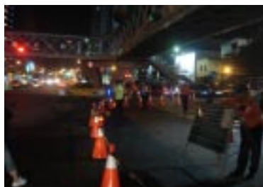
夜間施工之交通維持狀況
