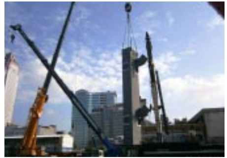
CA450B標D1工區鋼構工程吊裝
