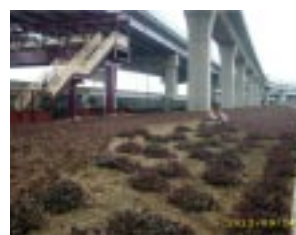
三重端工區植栽施作
