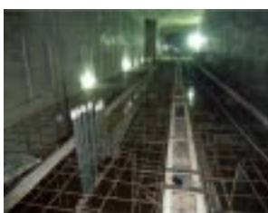
臺北端B03上行軌仰拱鋼筋綁紮
