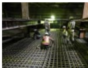
車站頂版鋼筋組立 及綁紮
