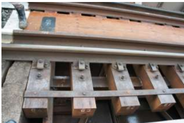
圖 54 京阪電氣鐵道宇治線之桁架鋼梁橋
