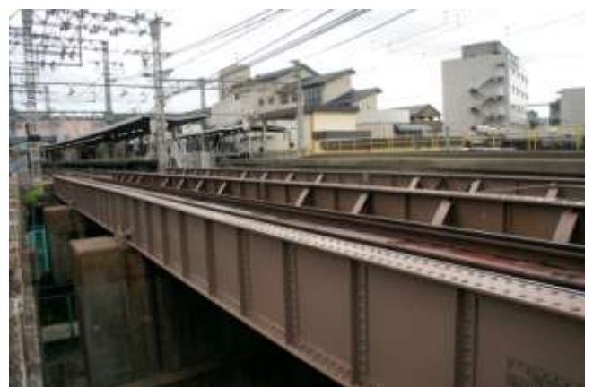
圖 53 京阪電氣鐵道宇治線之下承鋼梁
