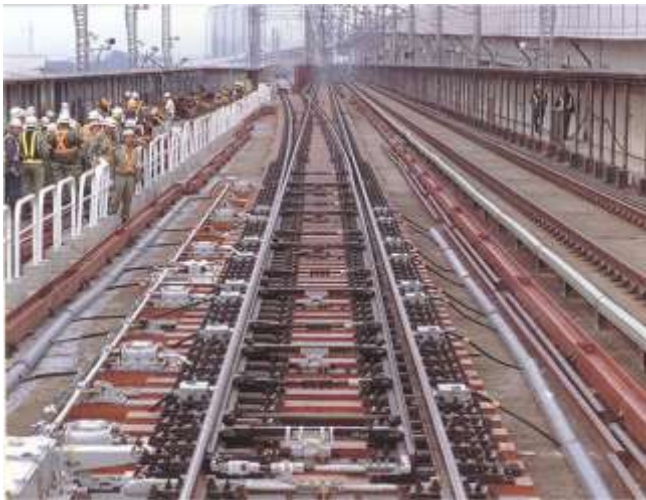
圖 45 日本上越新幹線的第 38 號道岔(日本最大道岔)上的 FFU 合成軌枕
