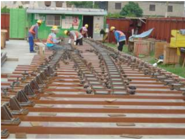
圖 47、48 臺灣高鐵機廠採用 FFU 合成軌枕
