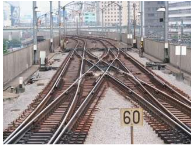
圖 46 日本東京站附近的枕木道床一體化彈性軌道的道岔上採用的 FFU 合成軌枕
