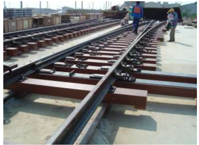
圖 47、48 臺灣高鐵機廠採用 FFU 合成軌枕
