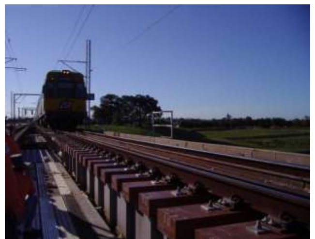
圖 50 澳大利亞 Queens Land 鐵道橋樑 FFU 合成軌枕
