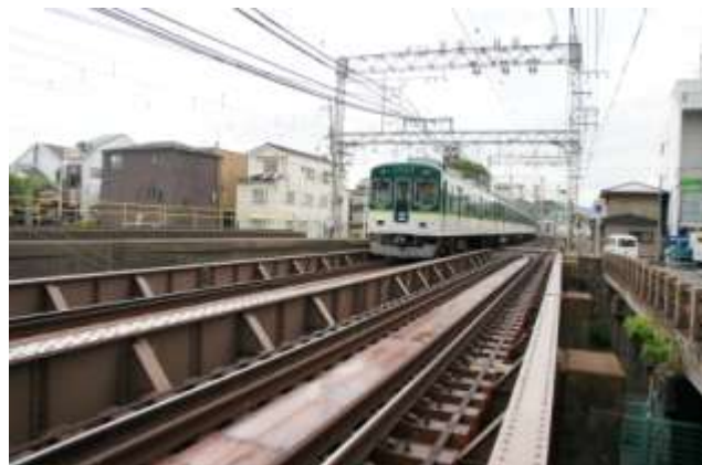
圖 55 安裝於京阪電氣鐵道宇治線桁架鋼梁橋之合成橋枕
