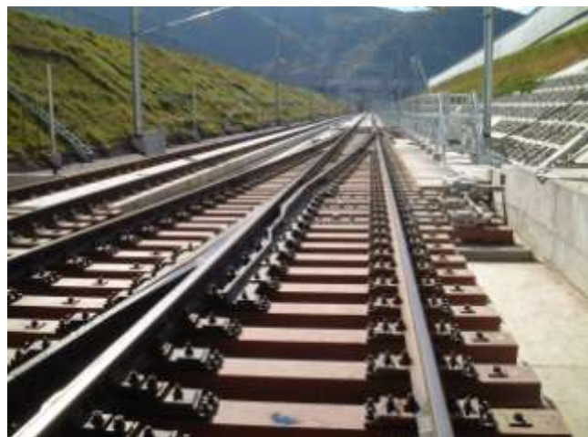
圖 44 日本東北新幹線的長鐵軌（64km）道岔上採用的 FFU 合成軌枕
