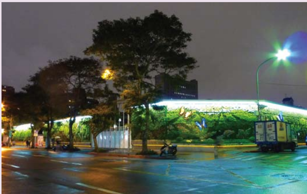
經過綠化植栽後的施工圍籬-大安區建國南路2段37號旁
