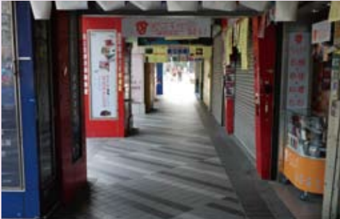
八德路一段電子街騎樓整平後現況
