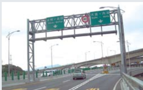
新生高架北端引道改建工程完工通車
