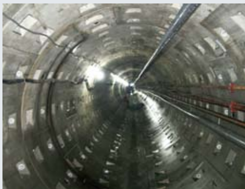
民生內湖線潛盾隧道完成環片組裝
