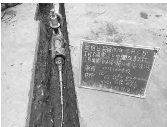
圖 13 管末端改善現場施工照片
