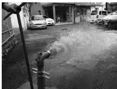
圖 1 現場排水照片
