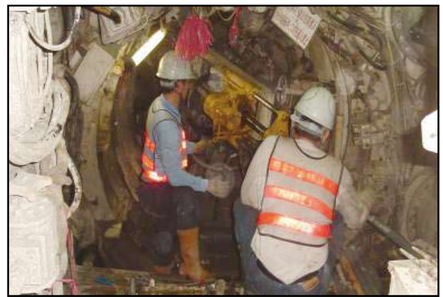
圖12 機內灌漿作業
