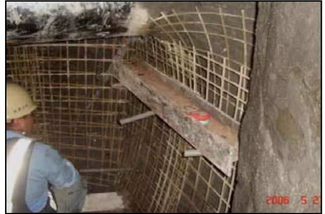
圖14 掛網支撐施工
