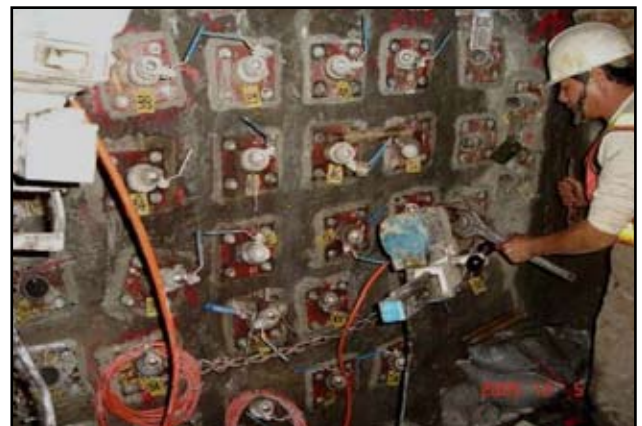
圖16 壁後灌漿施工情形
