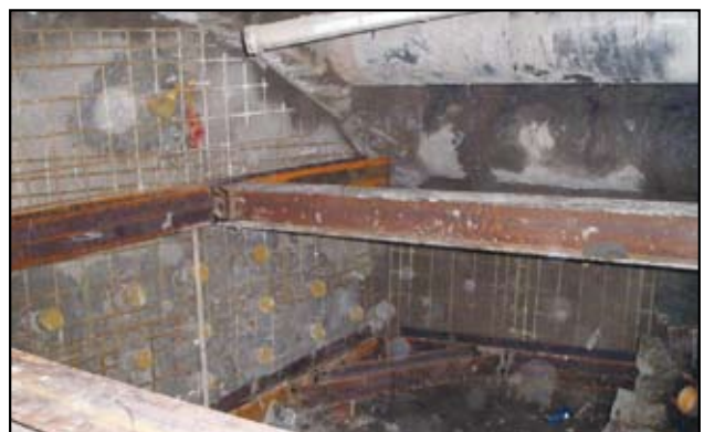
圖26作業空間設置及其灌漿預埋件
