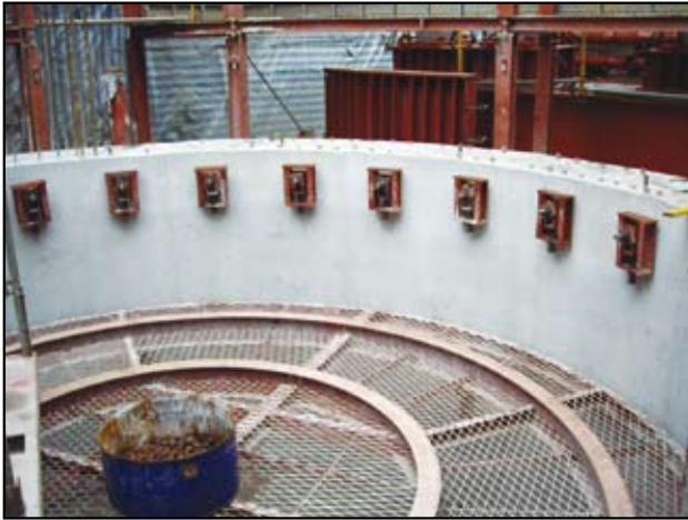
圖9 沉箱內側工作平台設置
