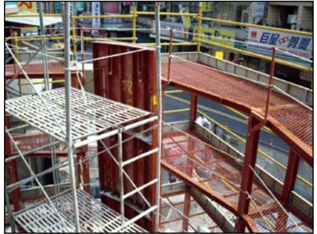
圖10 沉箱內模組立
