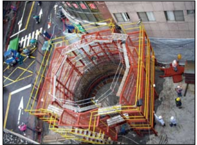
圖7 本工程使用之固定施工架
