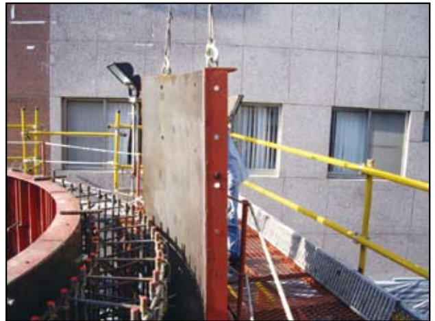
圖12 沉箱外模組立
