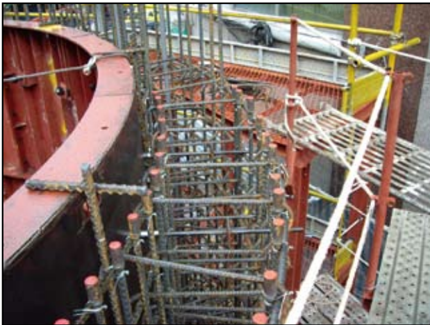
圖11 沉箱鋼筋綁紮
