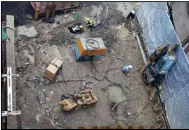
圖3 靜力式壓入鋼板樁 (SMP工法)
