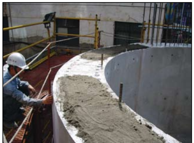
圖14 沉壓處設置清砂
