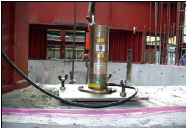
圖24 沉箱壓入千斤頂伸長
