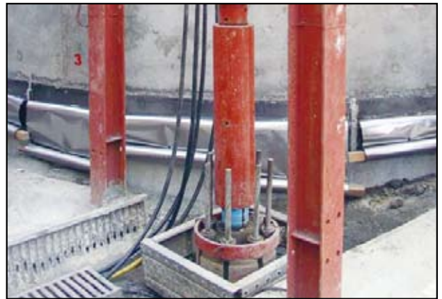
圖18 壓入樑與地錨間連接桿安裝
