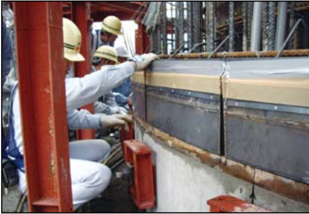
圖27 NF膜構件安裝
