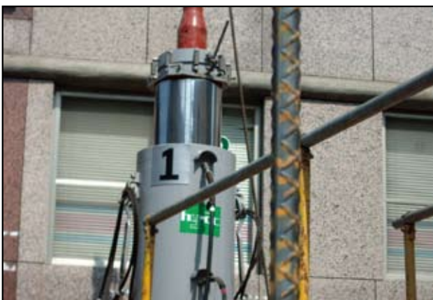
圖21 沉箱壓入千斤頂伸長
