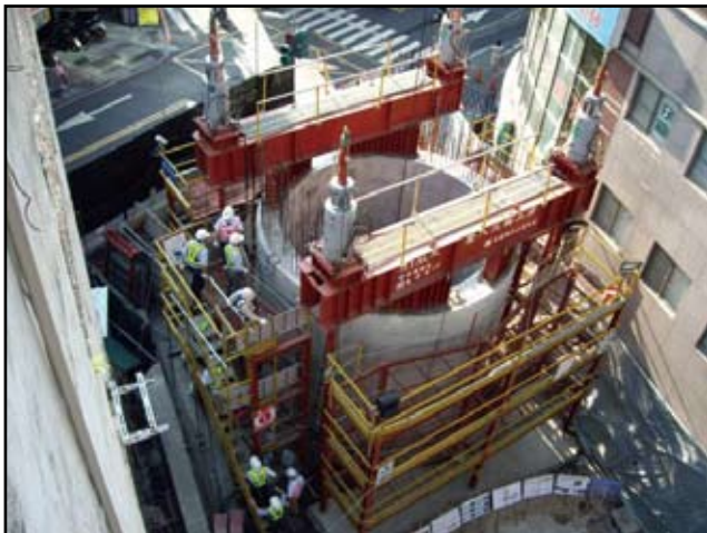
圖1 本工程壓入沉箱工法
