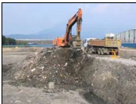
圖8 土方回填、PC樁打設
