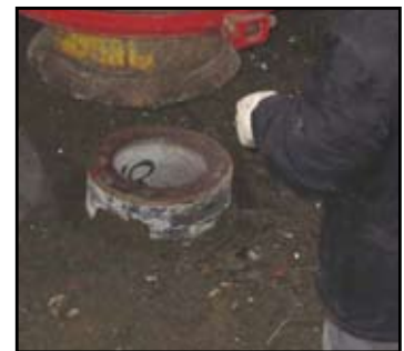
圖29 PC樁打設完成
