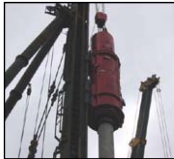
圖25 PC樁打設
