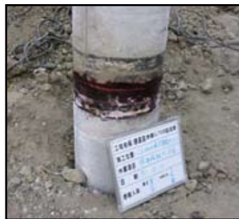
圖28 PC樁焊接檢驗
