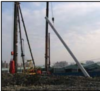
圖24 PC樁吊起定位
