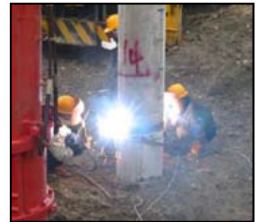
圖26 PC樁上下樁焊接
