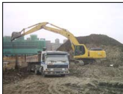
圖9 土方回填滾壓
