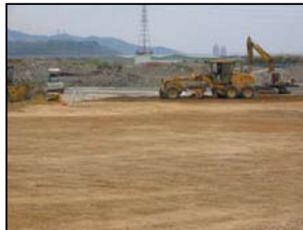
圖7 土方開挖運棄
