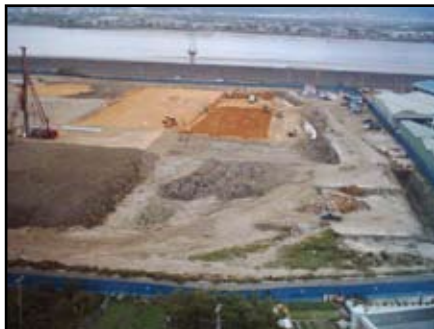
圖6 土方開挖運棄
