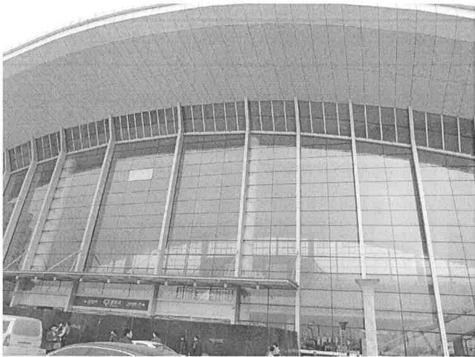
徐州市高鐵路站 部分設施施工中
