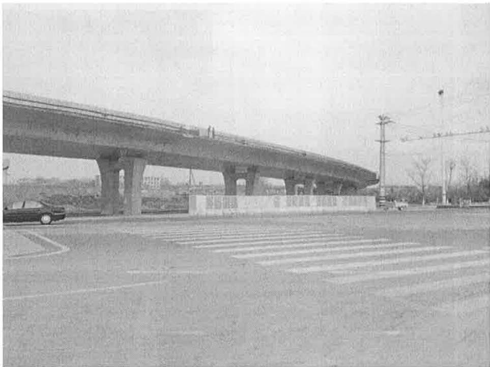
施工中之高架快速道路
