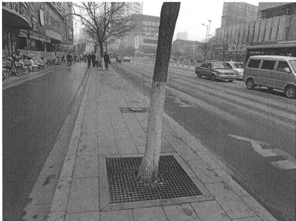
公車站臺植樹 鋪設樹穴蓋板以提升人行空間
