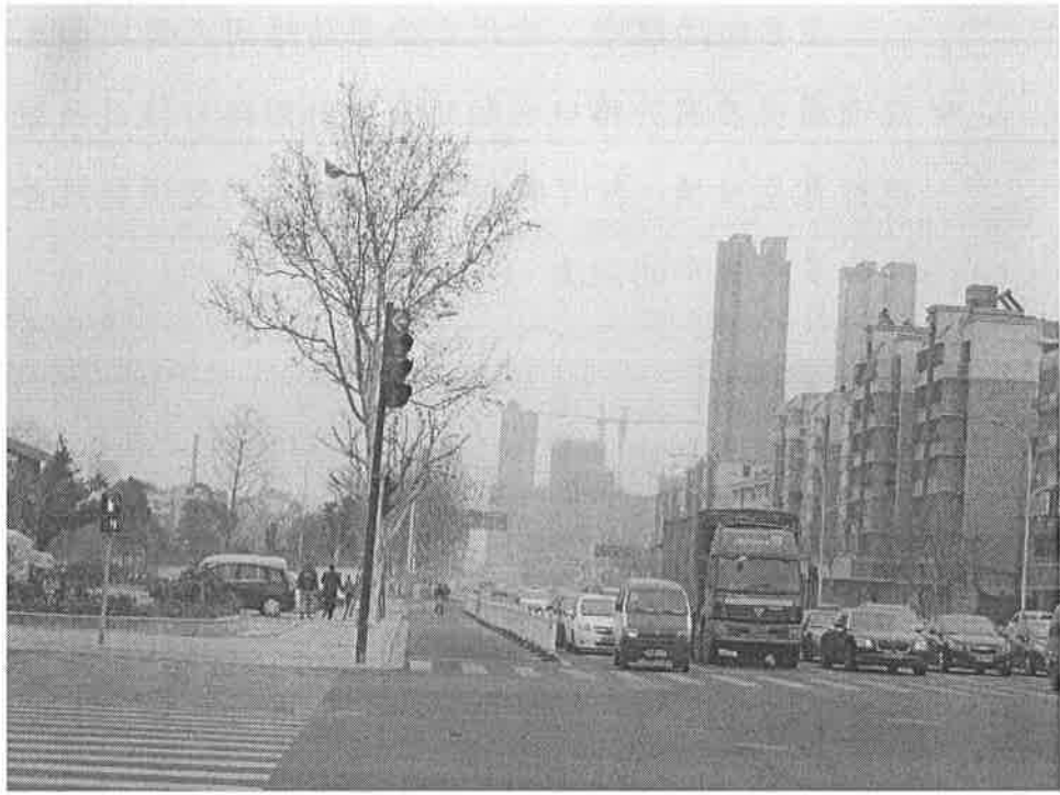
以護欄分隔機動車道及非機動車道
