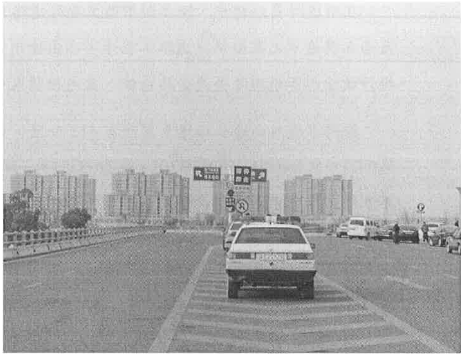
高鐵站前道路透過標線槽化及標誌規範動線及上下客行為
