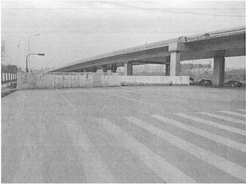
徐州市高架快速道路建設施工中 車道封閉採調撥措施
