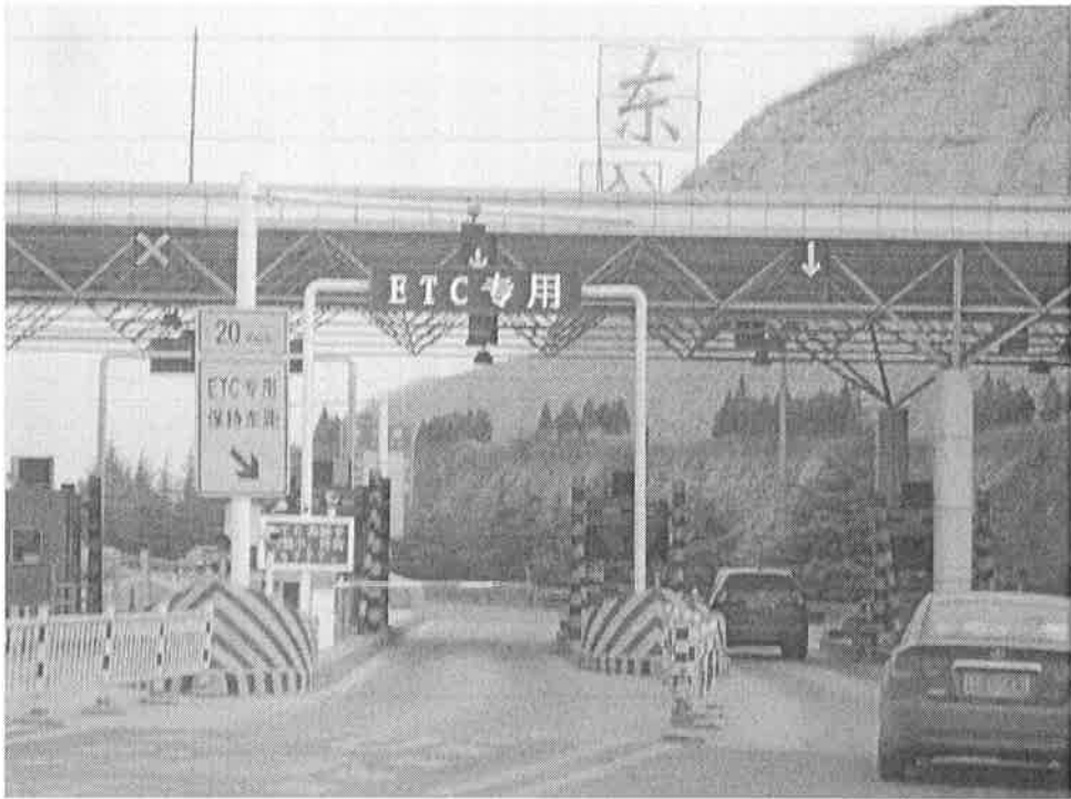
高速公路 ETC 專用車道及一般車輛車道
