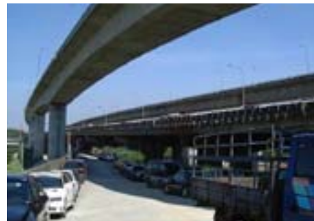
15 號河濱公園旁之現況
