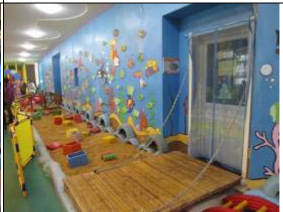
3-39 原廠房的邊溝覆蓋，設計成沙坑等區
