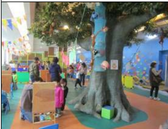
3-38 廠房改建，將大樑柱包覆成大樹
