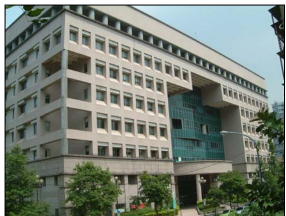
圖 7 松德大樓辦公室外觀
