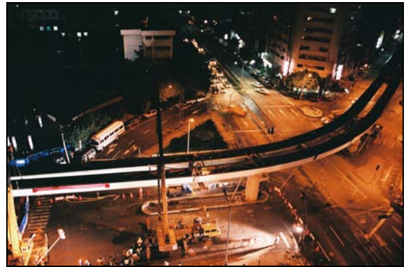
圖 15 最後一根大樑吊裝完成 (基隆路、和平東路口)
