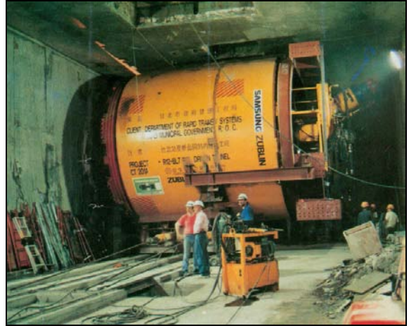
圖 5 C201A 工作井中的潛盾機
