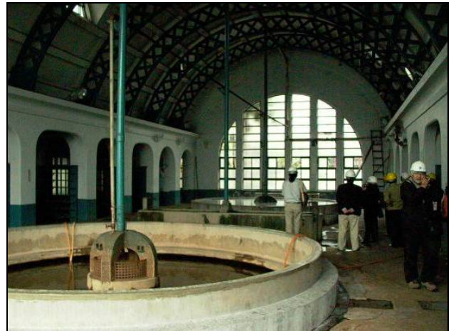
圖 19 台鐵台北機廠引用蒸汽廢熱來燒熱水，讓員工洗澡後才乾淨地回家（筆者攝於台北市）
