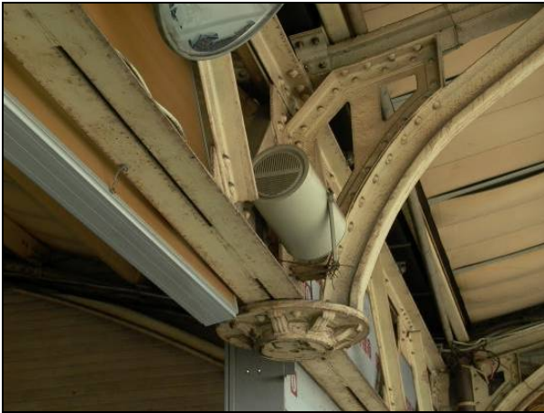
圖 18 台鐵老火車站的月台桁架多以卯釘技術來接合（筆者攝於嘉義市）
