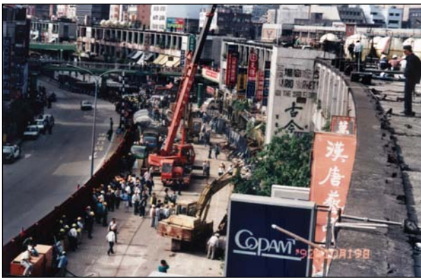
圖 3 中華商場拆遷現場
