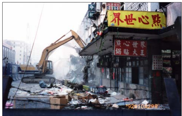
圖 4 中華商場拆遷現場
