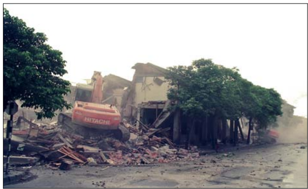
圖 6 南港機廠龍華四村拆除現場
