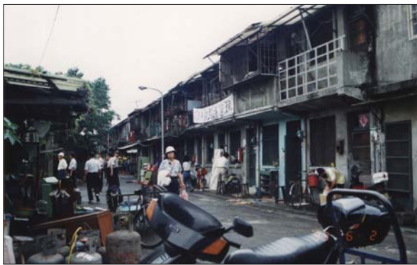
圖 5 南港機廠龍華四村拆除現場
