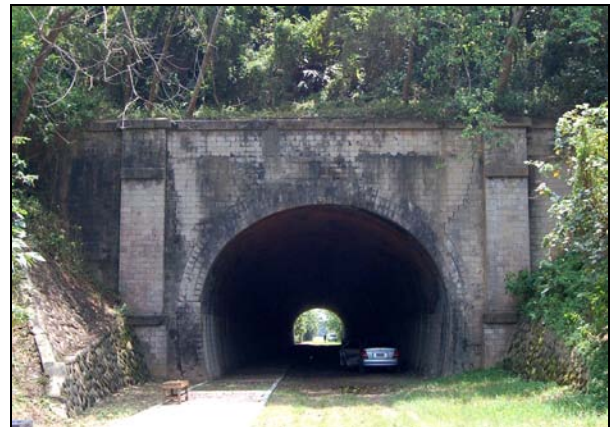
圖 14 獲得良好保存的縱貫線崎頂舊隧道
