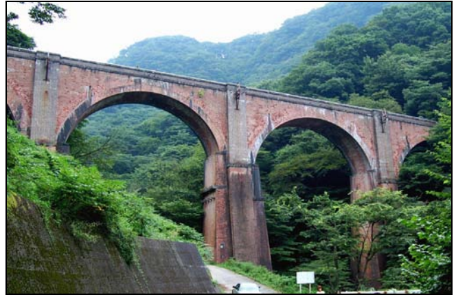
圖 6 日本所保存的信越線碓冰三號磚拱橋
