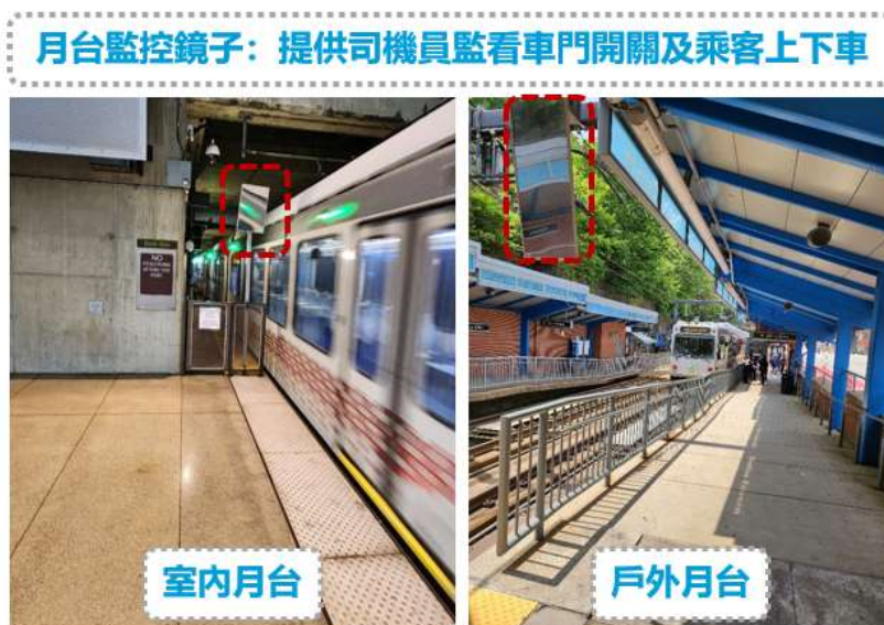
圖 31、匹茲堡區域運輸輕軌月台端牆門及司機員監控鏡子 (資料來源：出國人員自行拍攝)
