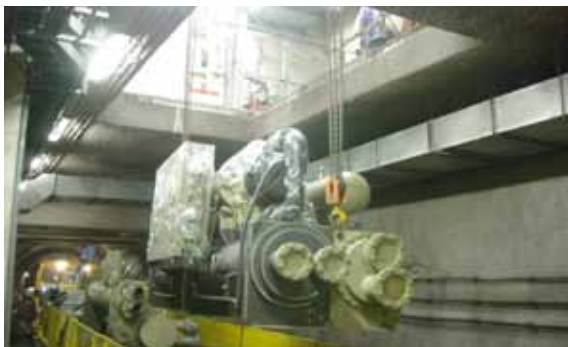
▲圖19 冰水機經由軌道上方吊裝口進場
