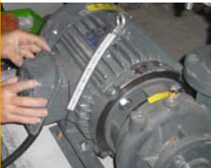
▲圖24 輔助冰水機泵浦安裝情形
