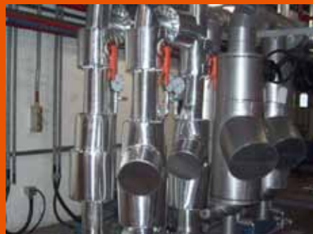
▲圖27 冰水管路完成保溫的情形
