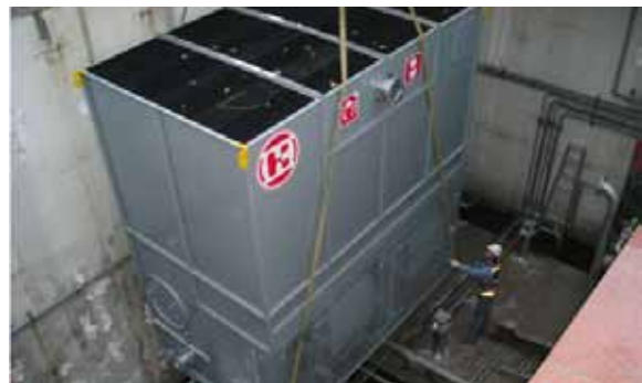
▲圖20 冷卻水塔吊裝情形
