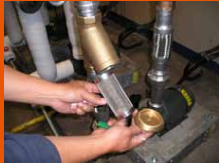
▲圖26 冷卻水循環系統之Y型過濾器安裝情形
