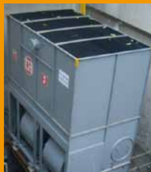
▲圖12 逆流式單側進風冷卻水塔外觀
