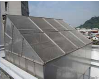
▲圖23 冷卻水塔出風口導風罩安裝情形
