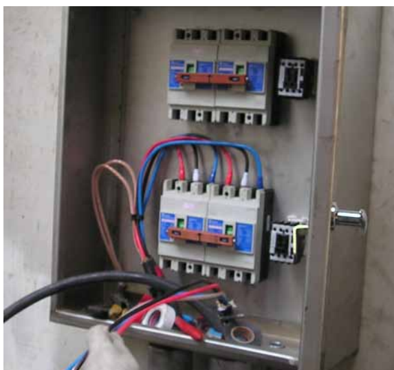
▲圖25 冷卻水塔之隔離開關安裝情形
