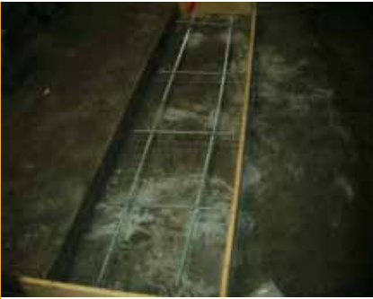
▲圖21 主冰水機基礎座修改
