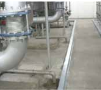
▲圖29 止水墩施作的情形
