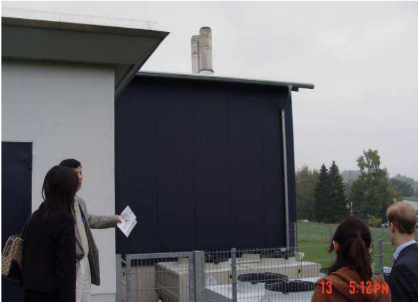
現場煙囪為無煙排放
