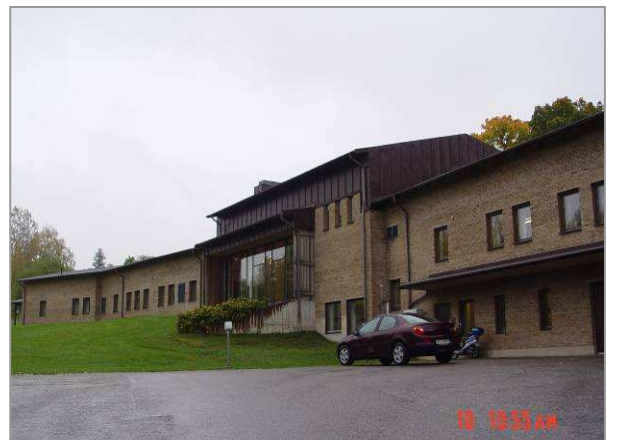
現場煙囪為無煙排放
