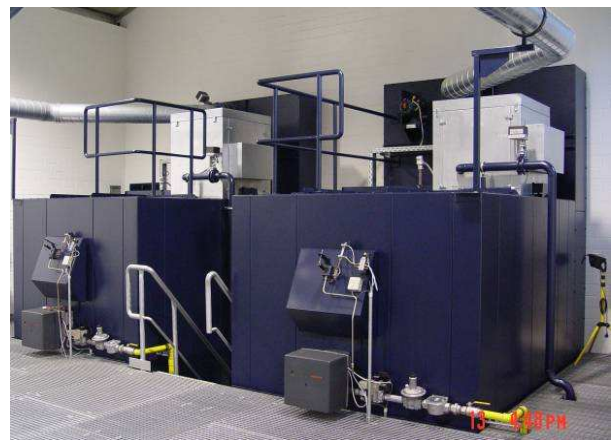
火化爐後方之主燃燒機及窺孔
