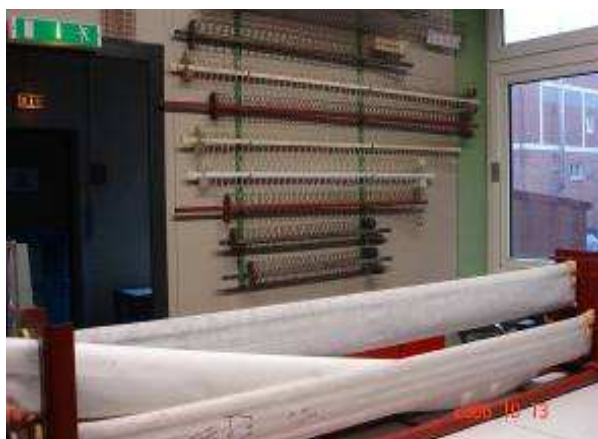
廠驗人員檢視濾器濾袋及支架
