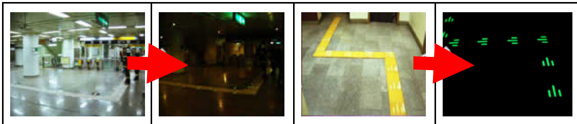
圖 3-2 南韓大邱地鐵車站避難標示改善，資料來源： http://itec-tyo.com/
