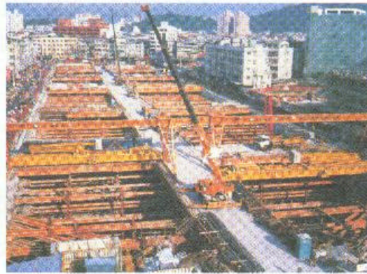
中和線南勢角場站施築
