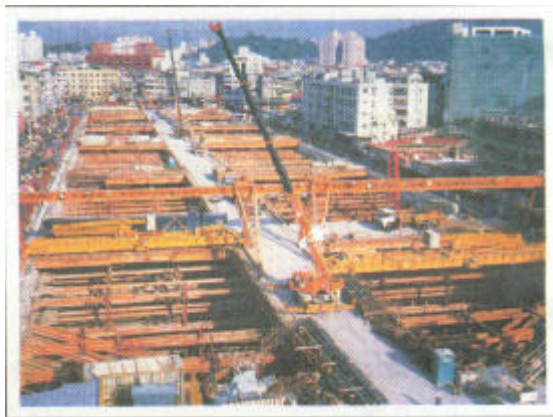
中和線南勢角場站施築
