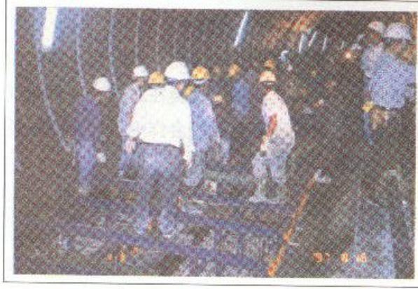
國外工程人員施作混凝土基座之情形
