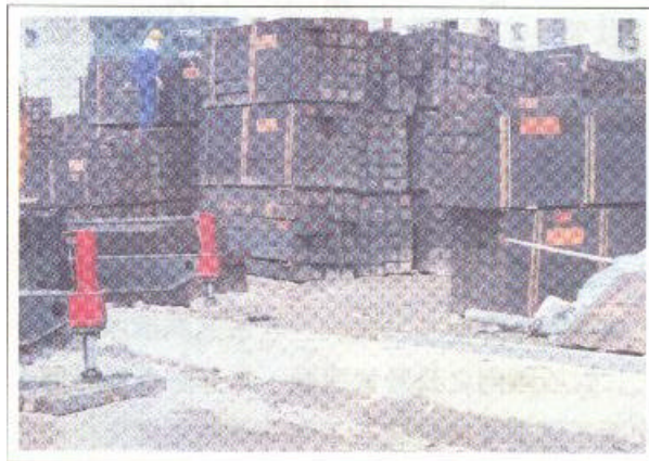
台北捷運自國外進口之枕木
