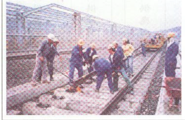
國外工程人員施作鋪軌之情形
