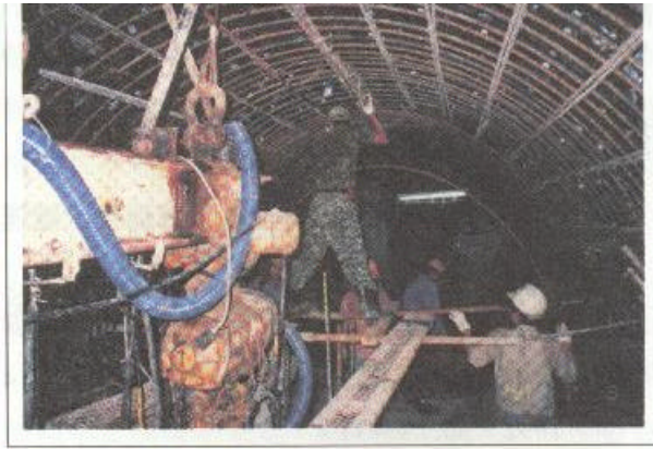
聯絡通道襯砌系統施工照片(CP 261 標)
