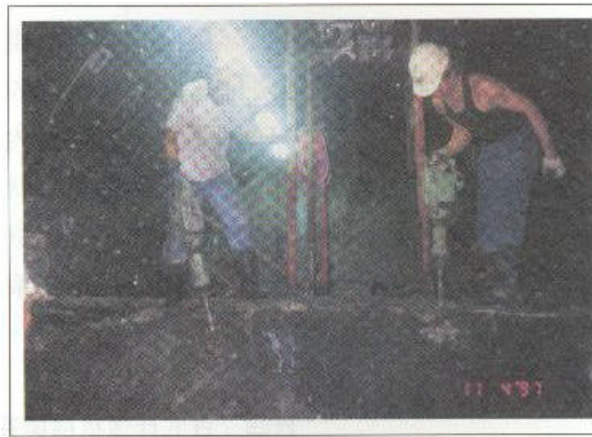
聯絡通道土壤開挖施工照片(CP 261 標)
