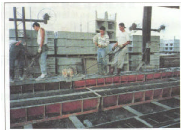
預力混凝土軌枕澆置情形
