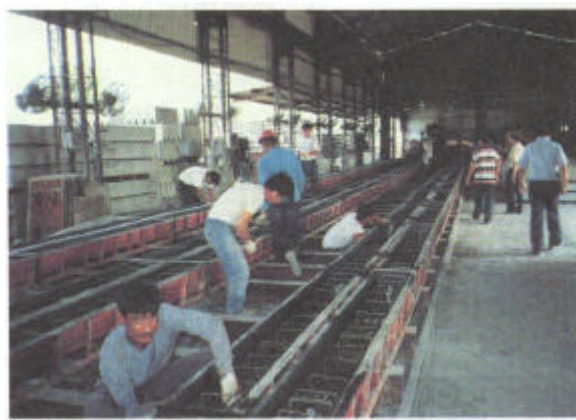
預力混凝土軌枕組模及澆置前準備
