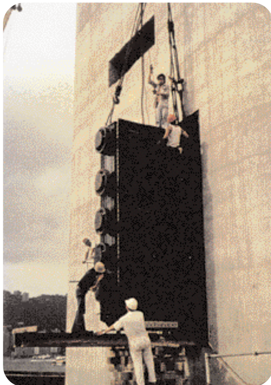
照片五 昇降移動式防水隔艙閘門吊裝情形（近處照相，可顯示人與閘門之比例）
