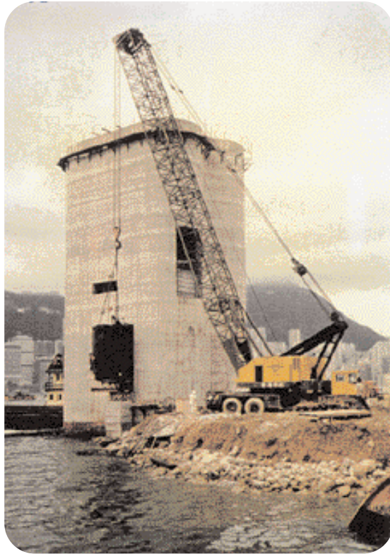
照片四 昇降移動式防水隔艙閘門吊裝情形（遠處照相）
