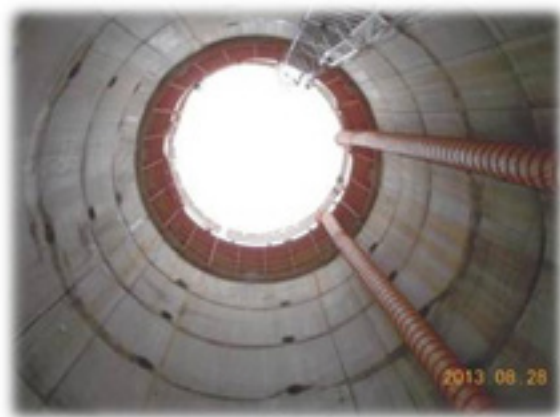
井基擋土壁體
