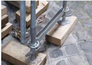
底座支撐以堅固之原木 墊平，避免施工架傾斜。
