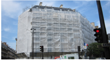
營造工程施工架。
