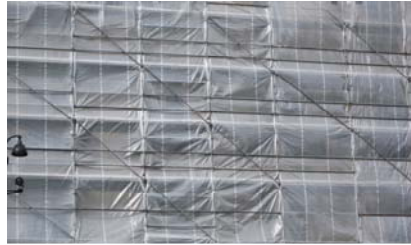
整體施工架輔以適當斜撐材補強 使整體強度受力一致。
