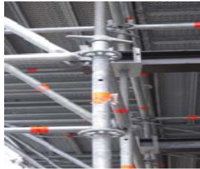
搭接處以嵌入式連結構件。
