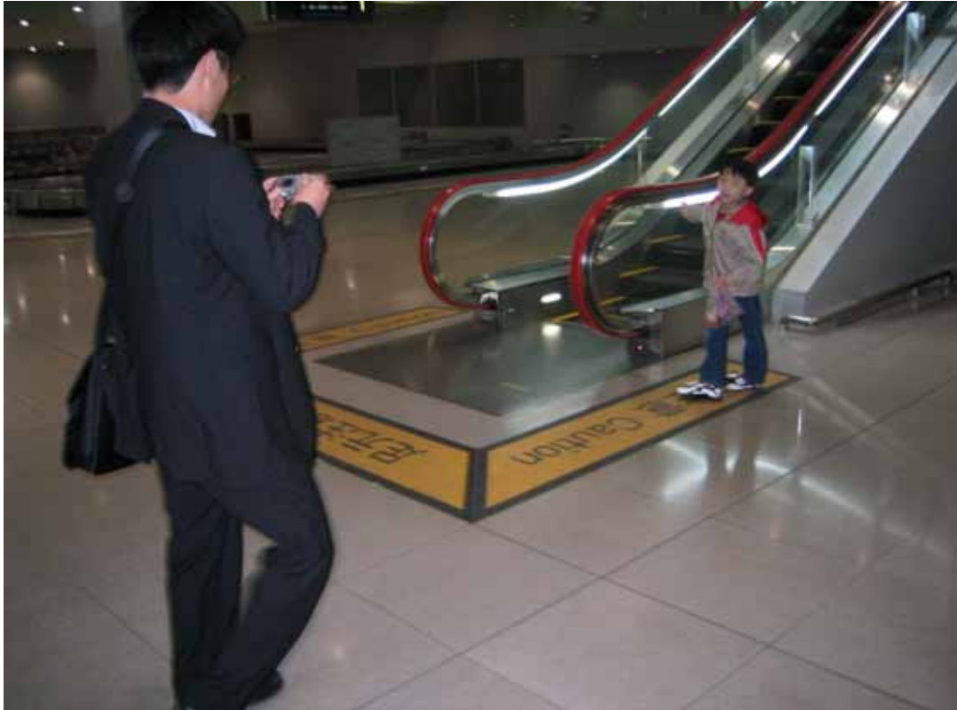
圖 27：電扶梯乘場警示標示
