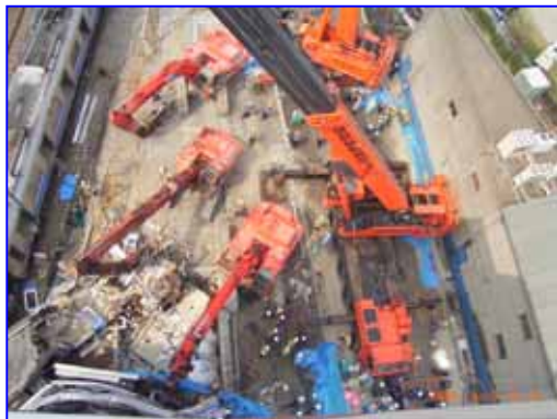
圖 21：大型機具拆除作業
