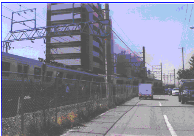
圖 9：第 4~7 節車廂出軌情形 (第一時間拍攝照片)
