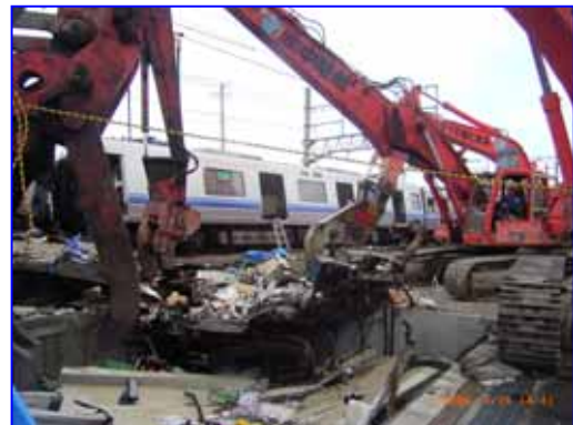
圖 22：大型機具拆除作業
