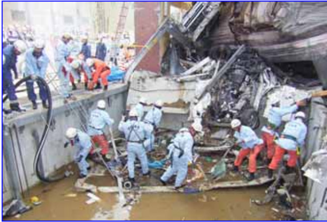
圖 6：第 1 節車廂撞擊大樓 1 樓 停車場北側損壞情形
