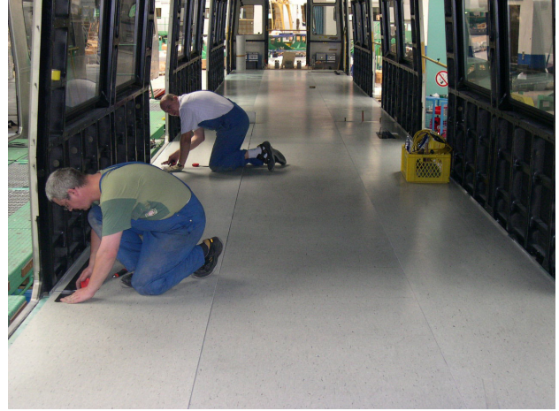
圖 4、電聯車地板安裝-鋪設橡膠地板
