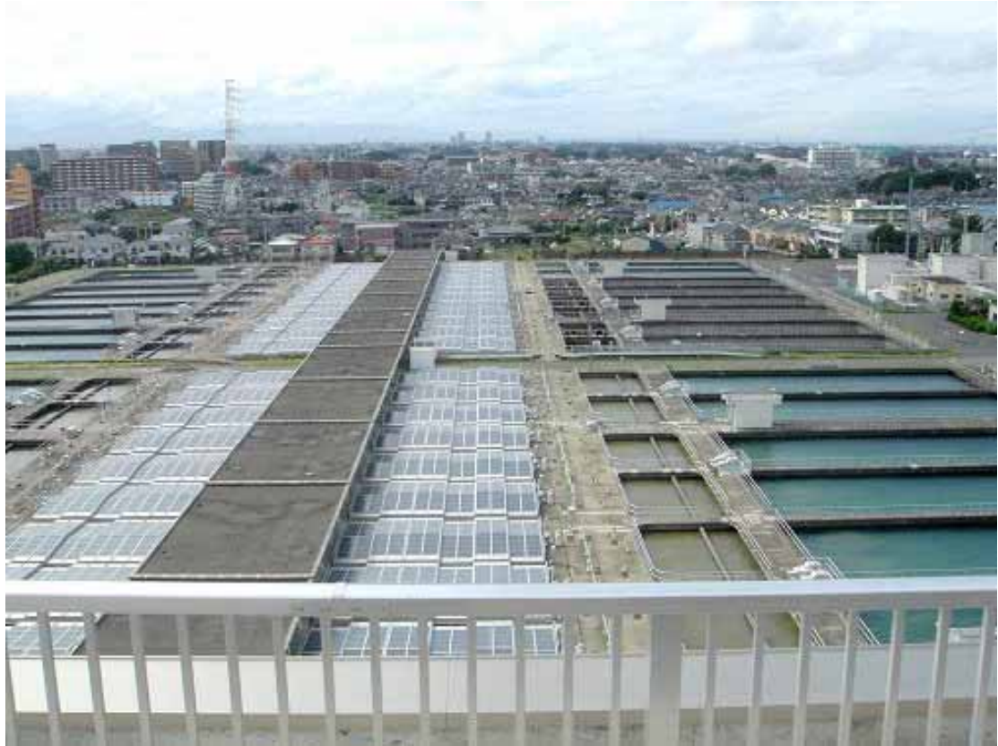
朝霞浄水場浄水設備單元
