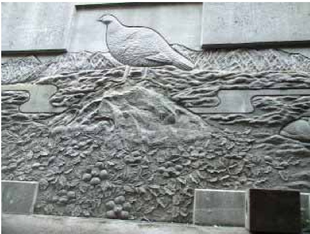
日本把當地特有的雷鳥等做成浮雕展現在擋土牆牆面上
