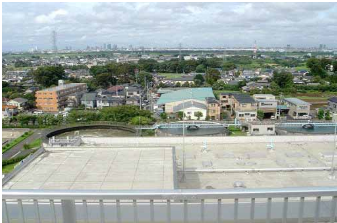
朝霞浄水場汚泥處理設備
