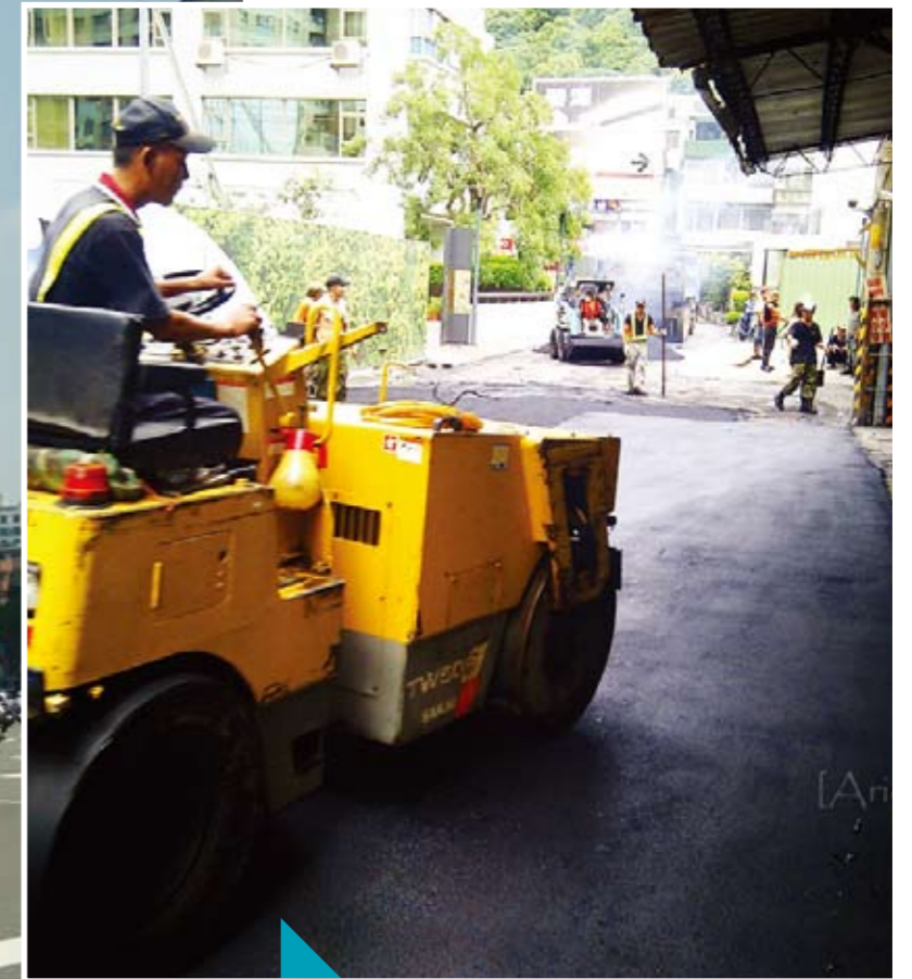
現代道路由特殊的鋪路機鋪上一層瀝青混凝土，再由大輪子的壓路車壓平。 (c.c by Flickr 炸丹丹)
