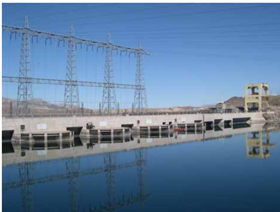
附照片 7 戴維斯壩上游面，發電進水口
