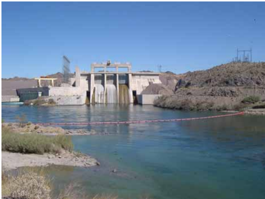
附照片 6 戴維斯壩下游面，圖中橫跨河道攔索用於阻擋下游舟艇
