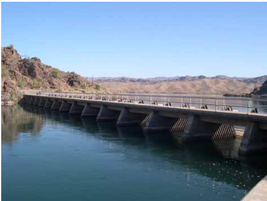
附照片 10 帕克壩發電進水口前攔污柵
