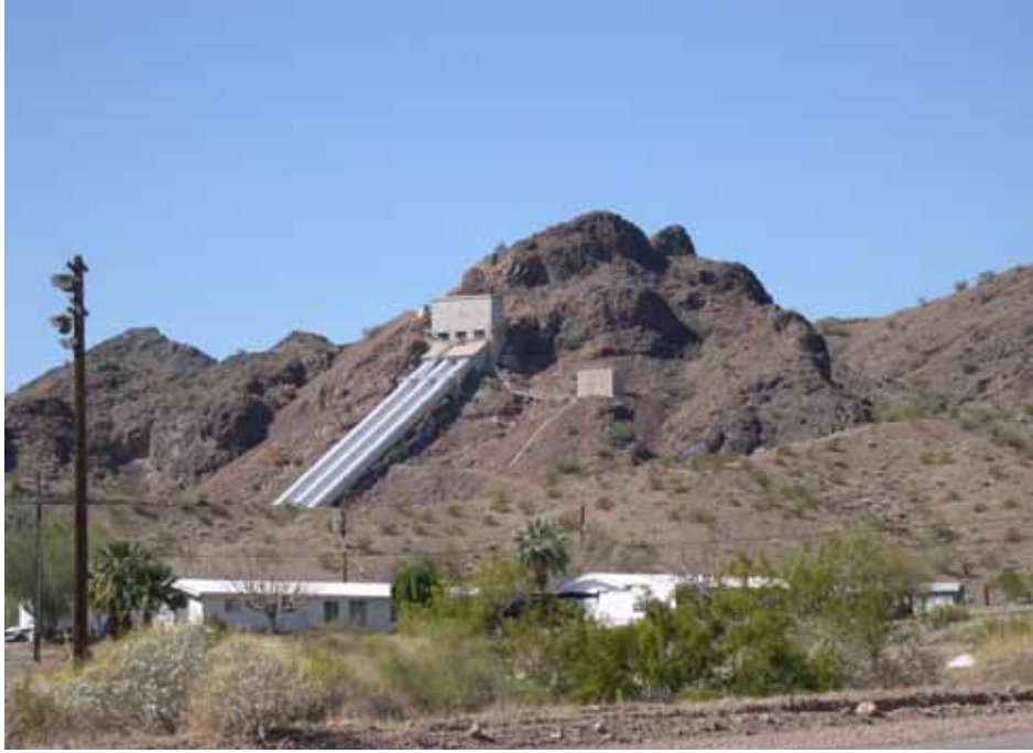
附照片 15 CAP 設施之源頭（六部抽水機，揚程 250 公尺）
