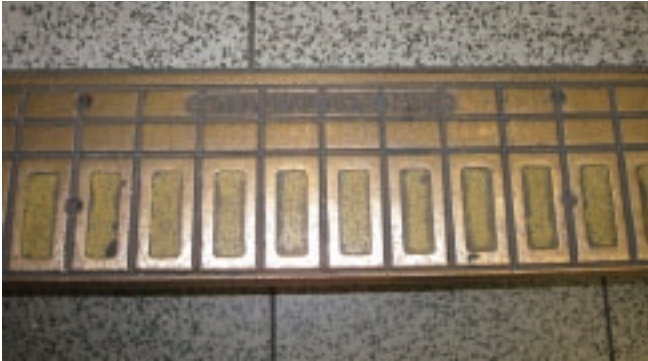
圖3&4 捷運車站樓梯地磚—特殊編號燒製之金屬釉面小口磁磚兼作梯級踏面轉角磚使用
