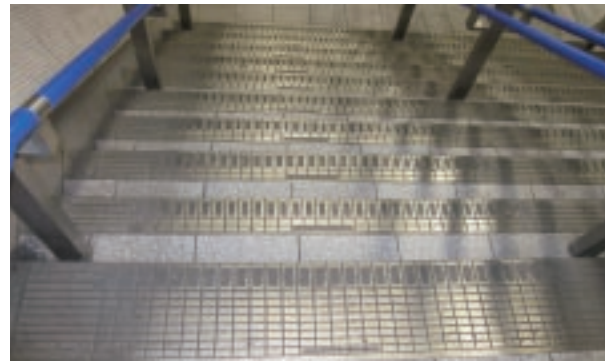
圖3&4 捷運車站樓梯地磚—特殊編號燒製之金屬釉面小口磁磚兼作梯級踏面轉角磚使用
