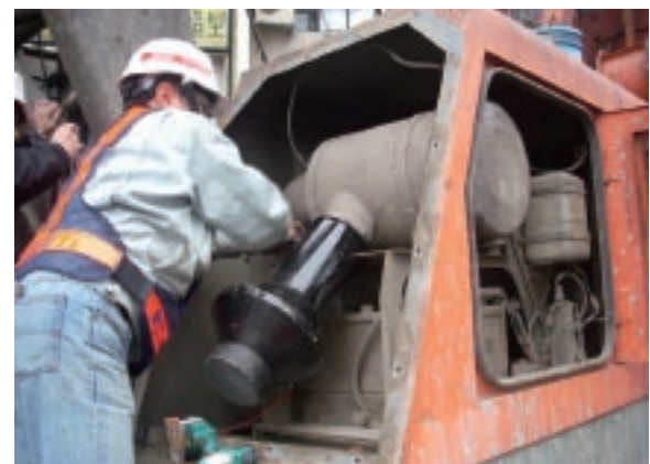
圖10 Gultima設備安裝
