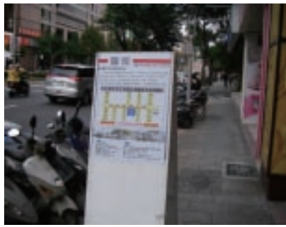
圖12 大型A形立牌說明施工範圍
