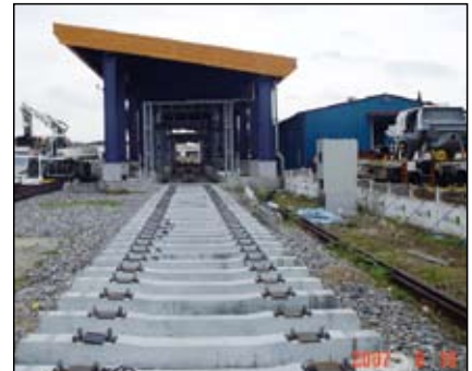
圖8 塑膠導角墊片、鋼軌墊片組裝於PC枕上
