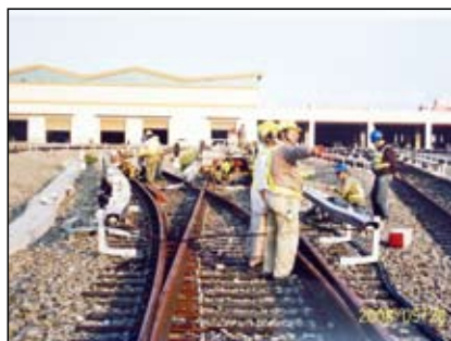
圖46 導電軌對導電軌直流電阻測試(聯結端)
