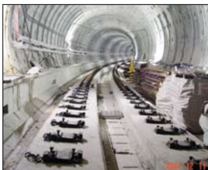
圖16 彈性基板組裝在混凝土基座上一景
