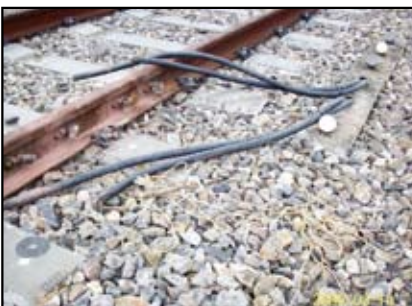
圖37 拆除後之軌道電路
