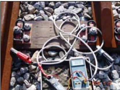
圖51 護軌對鋼軌電阻測試
