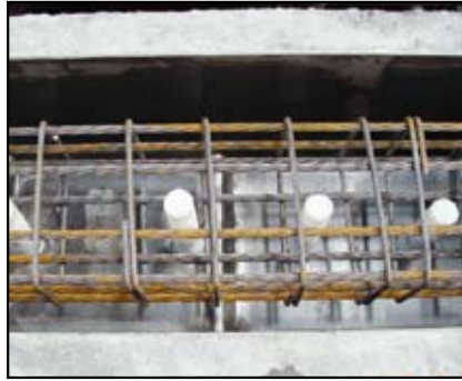
圖4 PC枕鋼軌扣件螺栓及導電軌支座螺栓預埋件於混凝土澆置前鎖固於倒置之鋼模上一景
