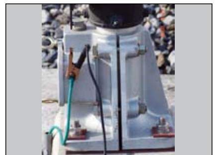
圖44 鋼軌(導電軌)對地電阻測試(接地端)
