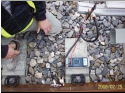
圖48 導電軌/鋼軌連續性測試 (聯結端)
