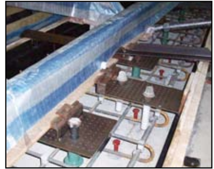
圖5 無道碴道床澆置前一景 (含：彈性基鈹螺栓預埋件【綠】、導電軌支座螺栓預埋件【白】、結合道釘【紅】)
