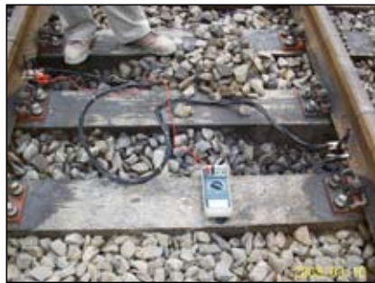
圖40 鋼軌直流電阻測試 (聯結端)
