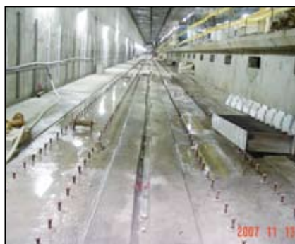
圖20 結合道釘植筋於土建標完成之仰拱面上
