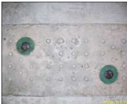
圖13 研磨前之混凝土基座承載面與彈性基板螺栓預埋件
