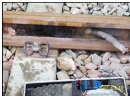
圖38 拆除軌道電路以執行電 氣測試
