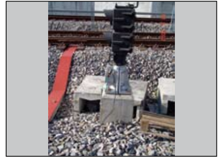
圖50 導電軌(鋼軌)對地電阻測試 (接地端)
