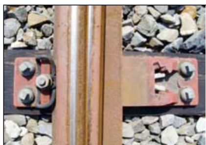
圖4 傳統式滑床板
