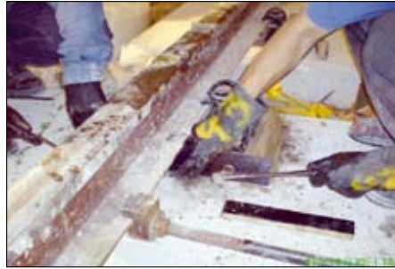
圖12 ERC塞漿工法施工情形
