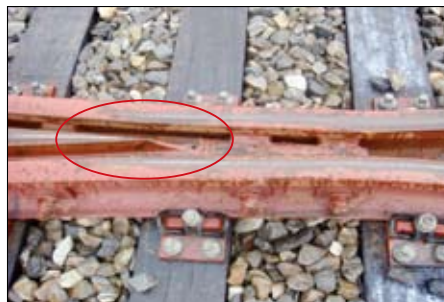
圖9 新蘆線岔心提高鼻軌鼻心趾端
