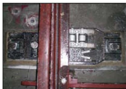
圖6 無道岔段滾輪式滑床板
