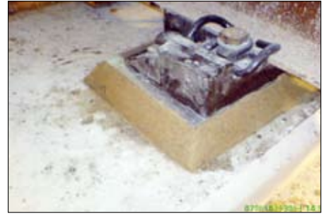
圖13 ERC塞漿工法完成情形
