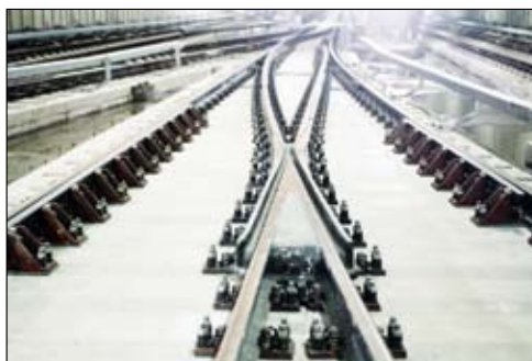
圖2 整體錳鋼型岔心
