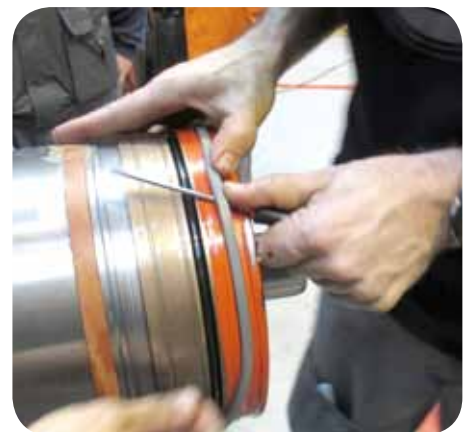
▲ 圖 13 安裝張緊液壓缸油封
