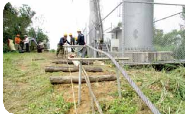
▲ 圖 6 架設剪纜工作平臺
