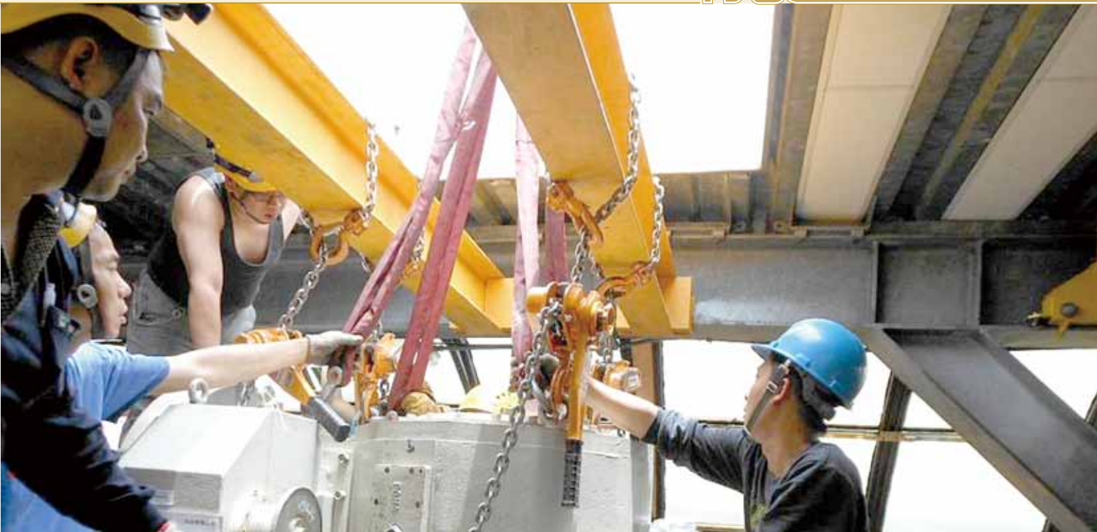
▲ 圖 9 以吊掛鋼樑配合鍊條吊車進行齒輪箱拆裝作業
