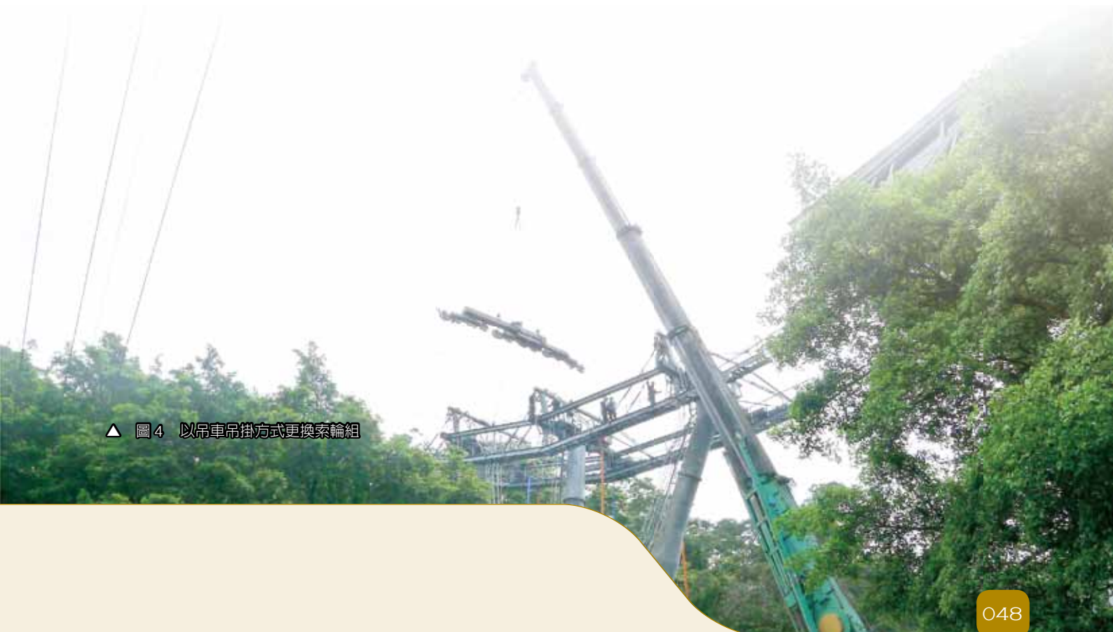
▲ 圖 2 雙握索器吊運索輪組抵達塔柱
