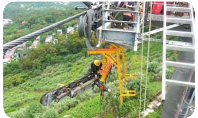
▲ 圖 3 將拆下之索輪組掛上雙握索器
