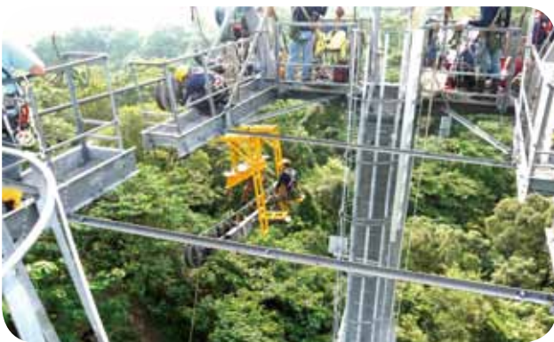
▲ 圖 2 雙握索器吊運索輪組抵達塔柱
