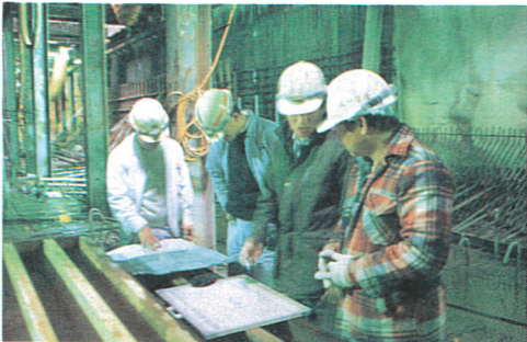
工程人員研討施工進度
