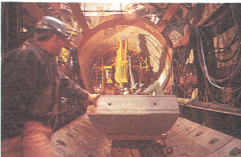
潛盾隧道環片組立
