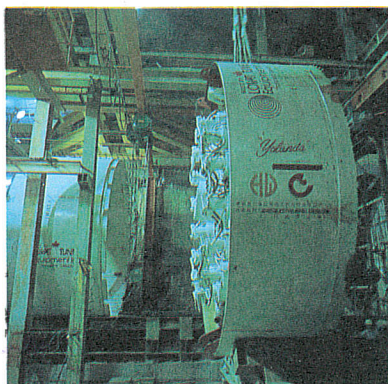
南港線258標潛盾機組裝
