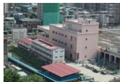
主變電站施工現況
