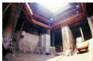
三重明挖覆蓋段 工作井結構施工
