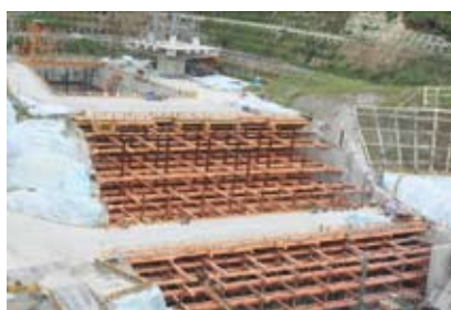
明挖覆蓋段隧道開挖支撐現況
