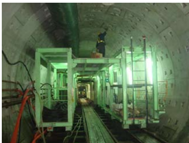
土城線延伸頂埔段工程潛盾隧道施工作業
