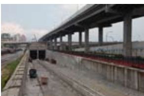
出土引道段 電纜槽溝施工
