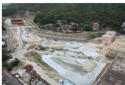
護坡工程施工現況
