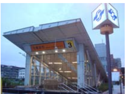
先嗇宮站出入口
