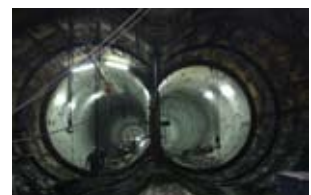
潛盾拆機及隧道貫通
