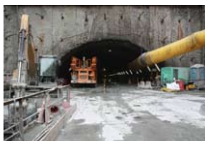
山岳隧道工作井與工作構台新舊院區人行鋼構陸橋
