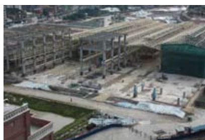
維修工廠施工現況
