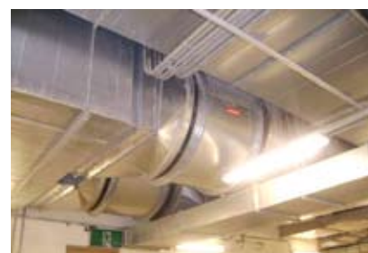
CK374A 主變電站送排風機
