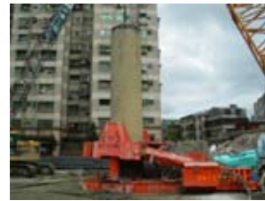
圖三十四、環狀線CF650-CF651A標秀朗橋站(Y8)全套管基樁挖掘
