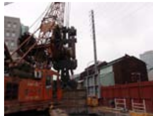
圖三十三、環狀線CF650-CF651B標中原站(Y13)連續壁施作
