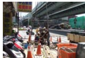
圖三十七、環狀線CF650-CF651A標景安站(Y10)永久水準點鑽設
