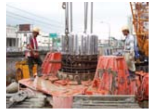
圖三十五、環狀線CF650-CF651A標秀朗橋站(Y8)試樁鋼筋籠搭接與吊放
