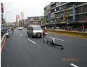
圖二十、環狀線IQUU01標板新路路面平坦度測試
