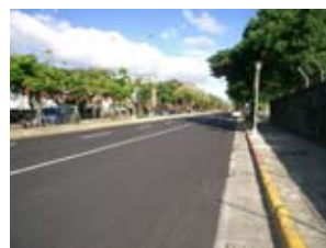
圖四十二、IZUX25標施作完工
