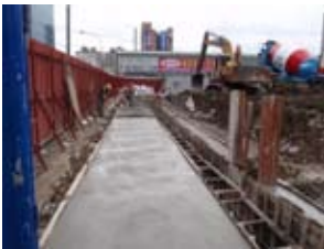
圖三十二、環狀線CF650-CF651B標中原站(Y13)連續壁導溝施作
