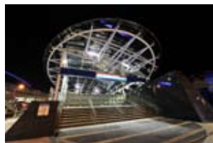
圖二、南港線東延段南港展覽館站出入口夜景
