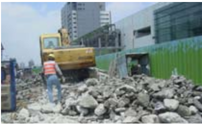
圖十三、拆除南港站3及4號出入口
