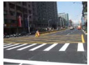
圖十九、環狀線IQUU01標板新路路面施工作業
