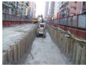
圖十七、環狀線IQUU01標板新路箱涵回填作業
