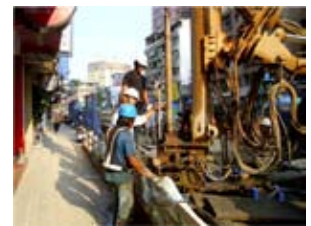
圖二十三、環狀線CF641標透水試驗鑽孔作業
