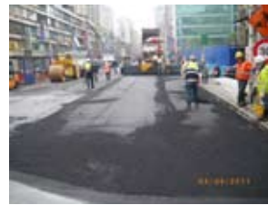
圖十八、環狀線IQUU01標路面瀝青鋪設
