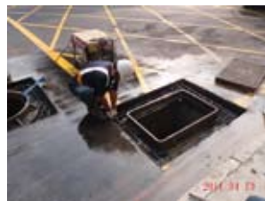
圖二十一、環狀線IQUU01標板新路永遷人手孔框座鋼筋綁紮
