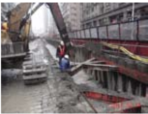
圖十六、環狀線IQUU01標板新路舊排水箱涵支撐架設作業
