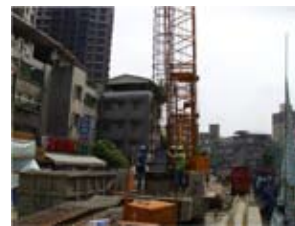
圖二十二、環狀線CF641標G1-042中間柱鋼筋籠吊放
