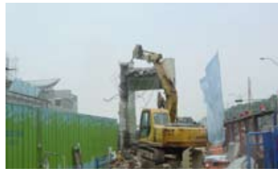
圖十四、拆除捷運南港站臨時電梯
