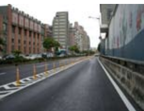
圖四十、IZUX24標施作完工
