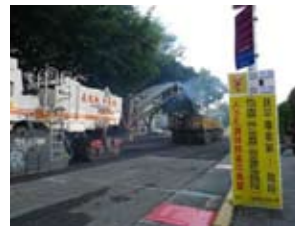
杭州南路依設計高程控制刨路機進行刨除圖
