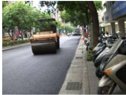
安和路瀝青混凝土加鋪後滾壓圖
