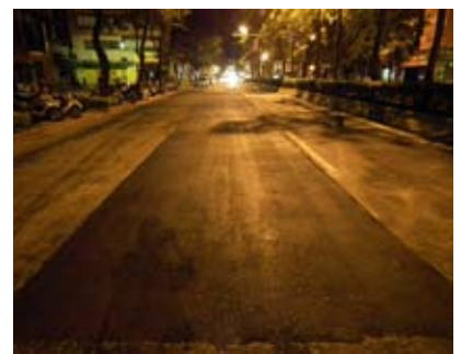
光復南路路基改善完成後路面圖
