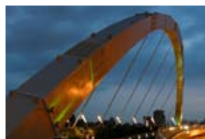
跨堤平臺主拱橋夜間照明實景圖
