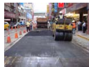
延平北路路基改善區塊級配改良後瀝青混凝土壓實圖
