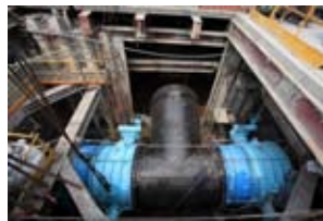
IRVX11標 \phi 2400mm清一內自來水管銜接工程圖
