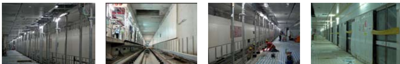
CK570H標 東門站月台層月台門施工及完成現況圖
