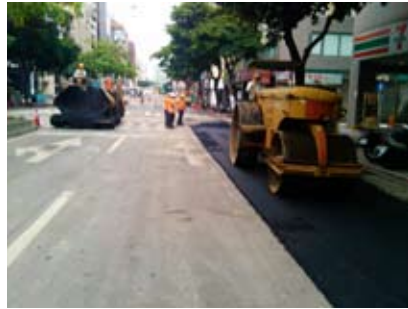
安和路路基改善完成後回填圖
