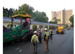
杭州南路鋪裝機瀝青鋪設進行與壓實圖
