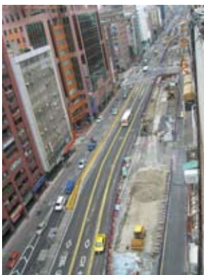
信義安和站路面回填及管線復舊圖
