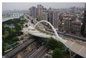
跨堤平臺主拱橋實景圖
