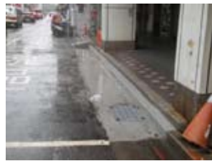
杭州南路L型場鑄排水溝蓋板圖
