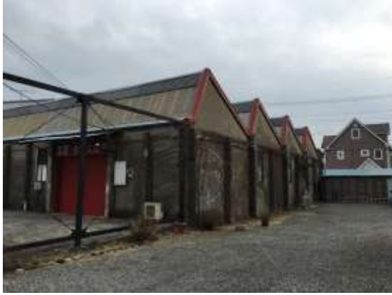
古街道巡禮--許鋸式屋頂工廠
