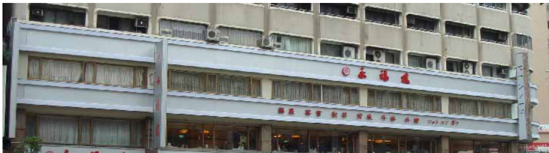
圖 4.4.3 永福樓新設 LED 招牌（白天）
