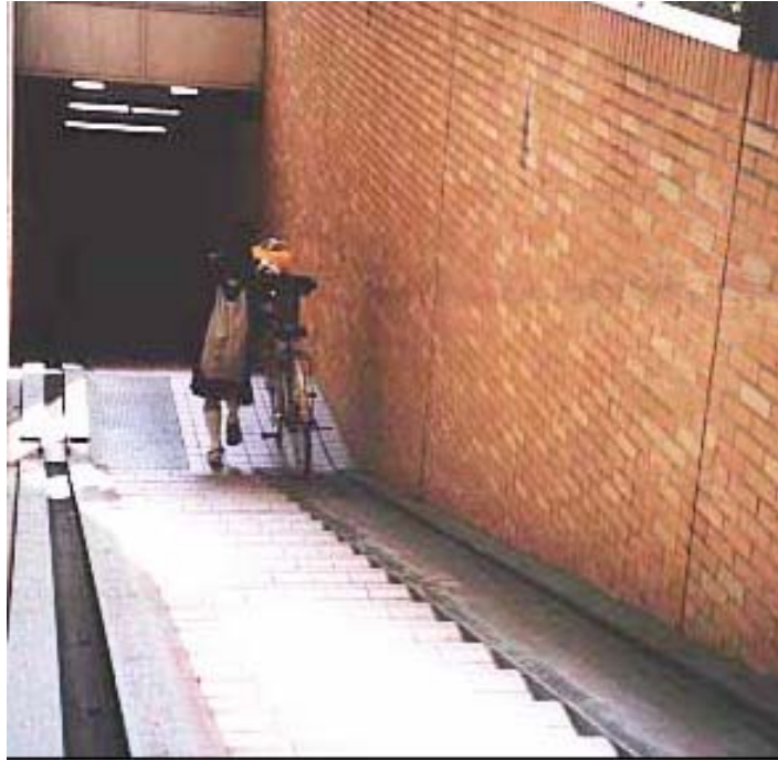
上坡備有輸送帶（左側）；下坡有輔助斜坡（右側）
