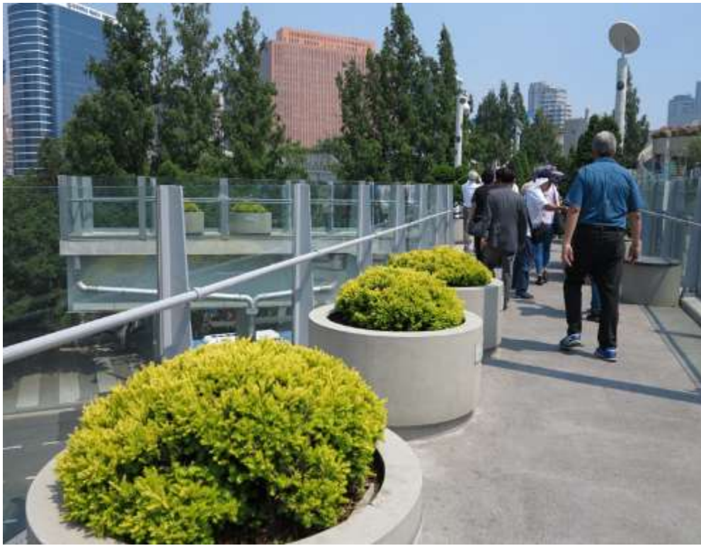
照片 13：昔日因安全考量面臨被拆除命運的高架橋，改造後變身為綠意盎然的空中花園步道
