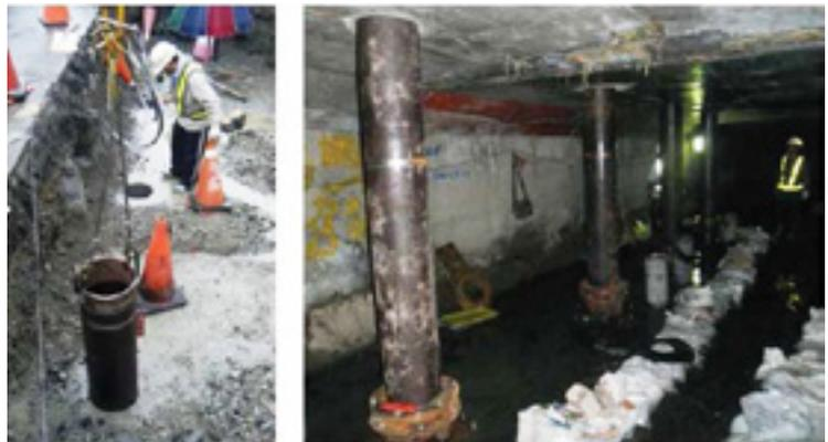
雙孔箱涵內埋設灌漿套管
