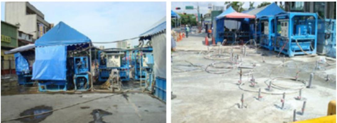
二重管雙環塞低壓灌漿工法
