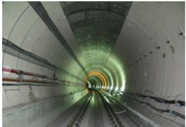
隧道吸音材料噴塗完成後現況
