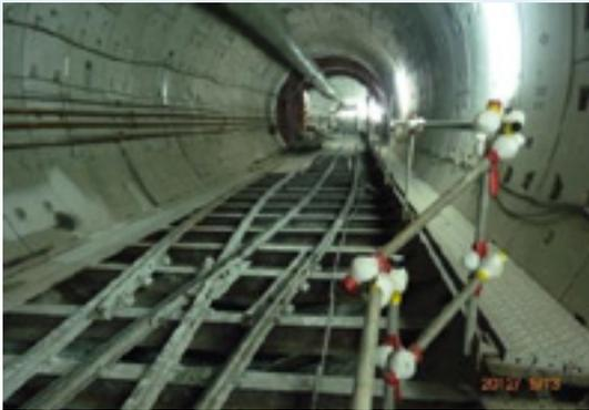
連絡通道施工區設置複線及岔式軌道
